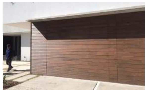
Portón y revestimiento realizado en fusión siding en tono lapacho
