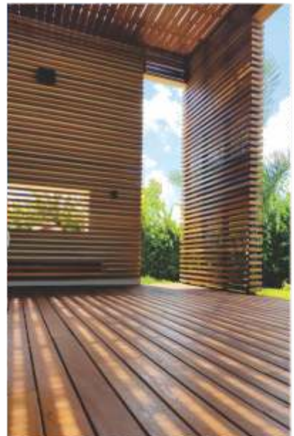
Pérgola realizada íntegramente en Madera Teka Petrea protegida con Cetol
