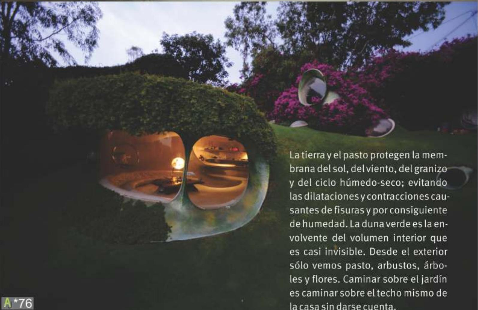
La tierra y el pasto protegen la membrana del sol, del viento, del granizo y del ciclo húmedo-seco; evitando las dilataciones y contracciones causantes de fisuras y por consiguiente de humedad. La duna verde es la envolvente del volumen interior que es casi invisible. Desde el exterior sólo vemos pasto, arbustos, árboles y flores. Caminar sobre el jardín es caminar sobre el techo mismo de la casa sin darse cuenta.
